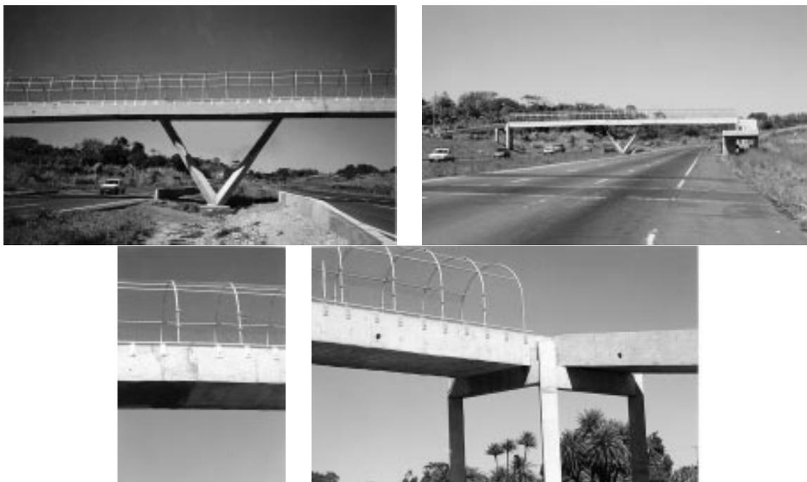
Figura 6.21: Passarela de pedestres: a) e b) vista geral; c) detalhe da rótula; d) apoio na rampa.
